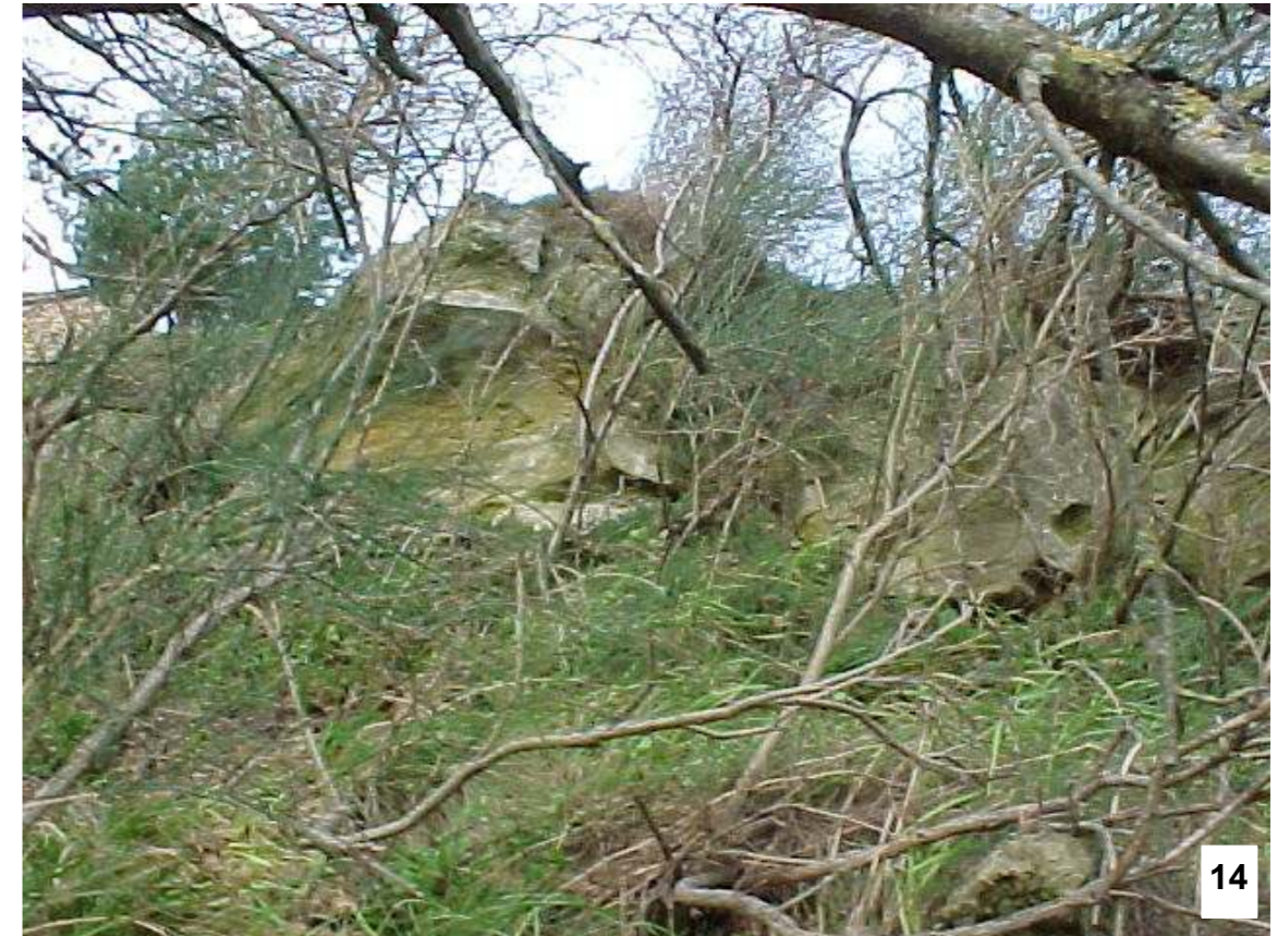
FOTO10-14: Viste della scarpata a monte della strada
