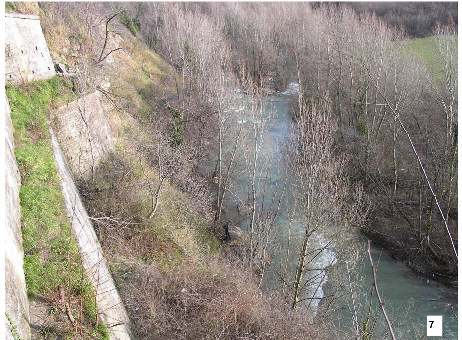
FOTO 4-7: Viste del muro da consolidare
